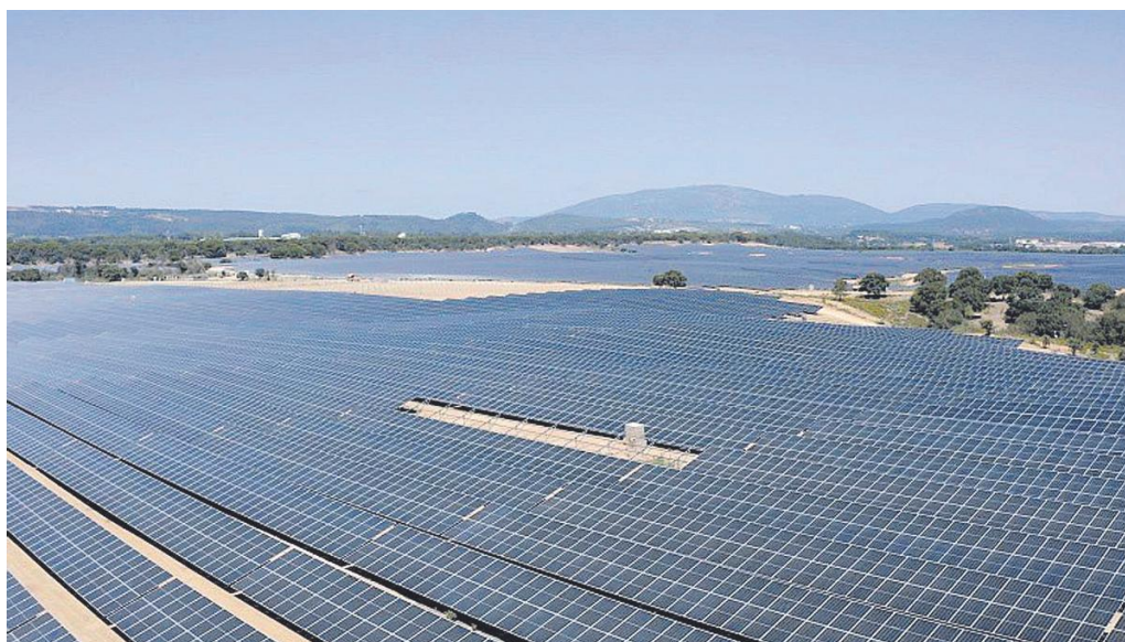
Placas solares de una megaplanta fotovoltaica. / Levante-EMV
