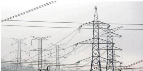
Instalación de torres eléctricas LV
