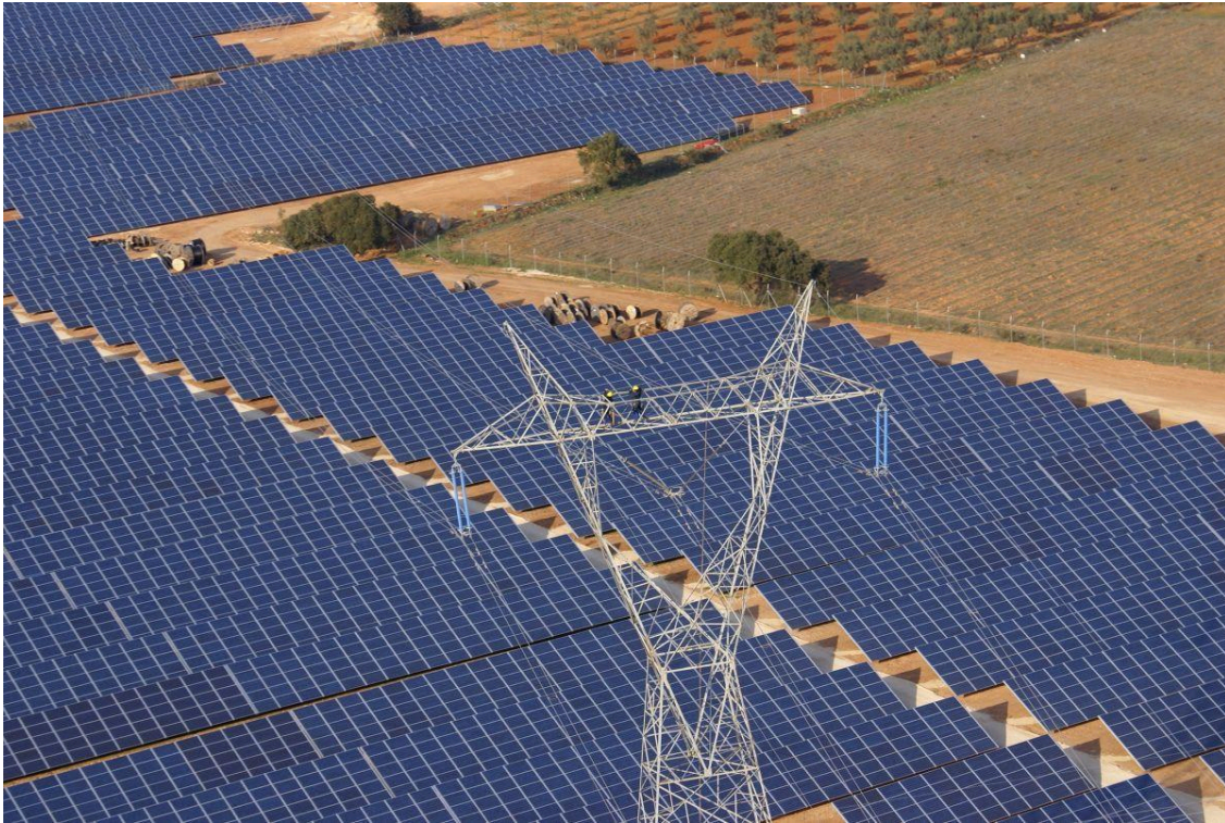
Dos operarios sobre la estructura de una torre de alta tensión. / Levante-EMV
