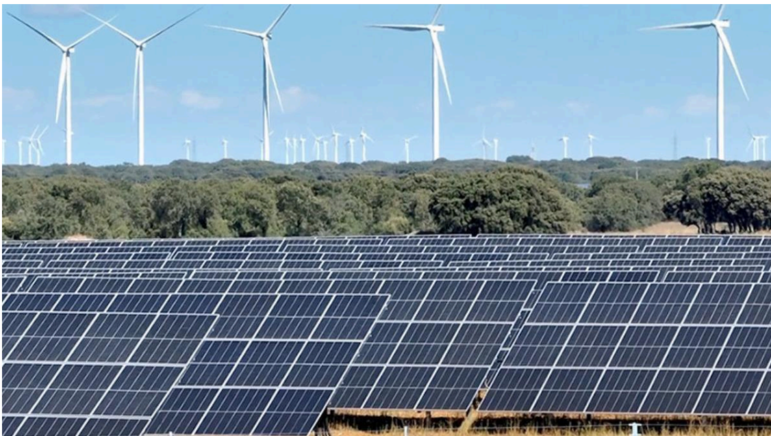
Parque eólico junto a una planta fotovoltaica. / Levante-EMV
