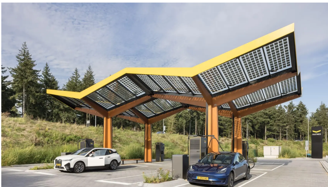
Estación de vehículo eléctrico de Fastned.
