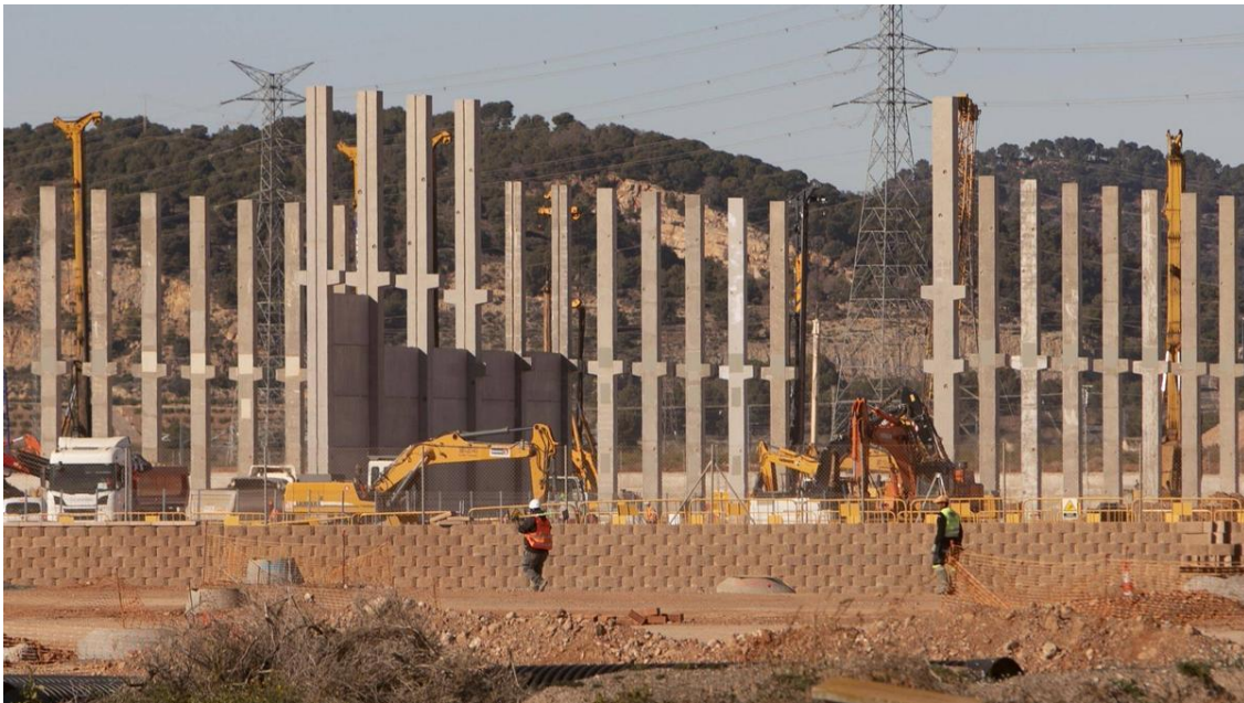
Avance de las obras de la gigafactoría de PowerCo en Sagunt, en una imagen captada el viernes. / Daniel Tortajada
